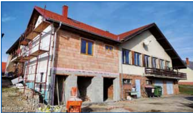
V Števanovcih se že izvajajo dela dograditve kulturnega doma.
