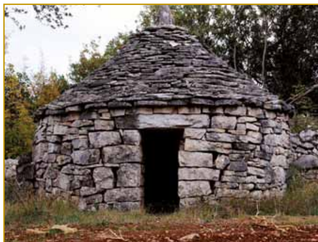
Kažun je na »süjo« zidani, kak tau v Istri pravijo. Za kažune se ne vej, od kda dale aj bi je zidali. Že od inda aj bi je lidge delali, prejk 2000 lejnt nazaj so je že v krajinaj skrak maurdja poznali. Kažun gnes za biser ljudske arhitekture vala.
