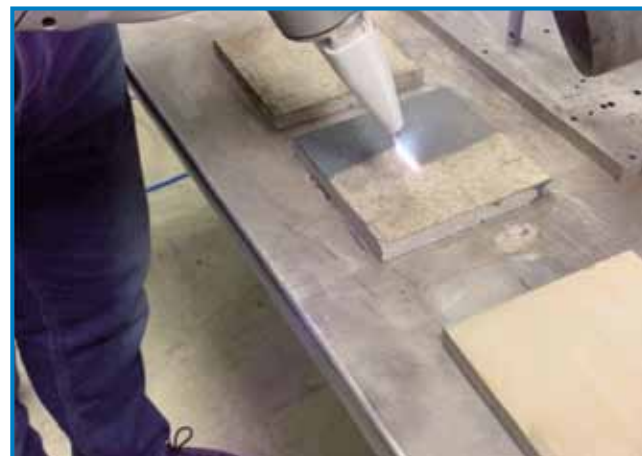
Lasersko čiščenje betona
